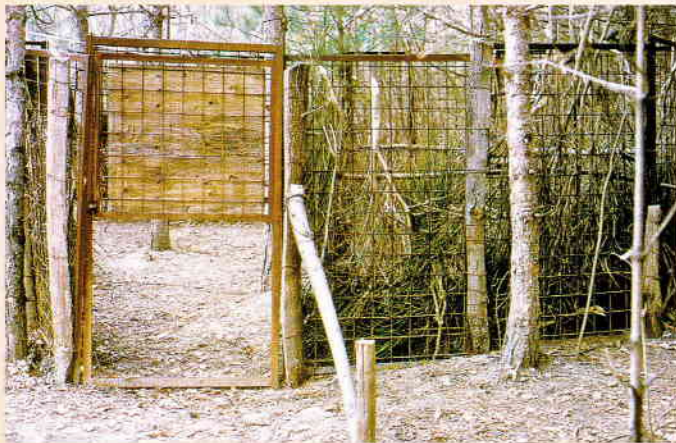
Figura 42 - Ancoraggio dei pannelli agli alberi circostanti.
