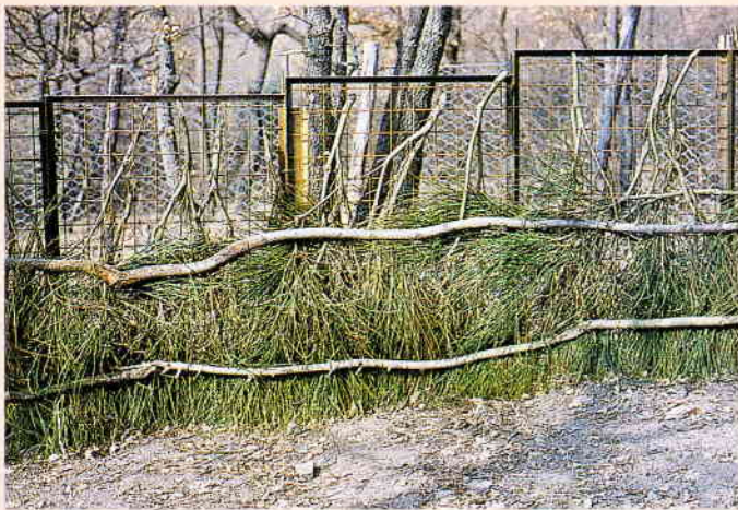
Figura 43 - Rivestimento del chiusino con fascine di ginestra.
